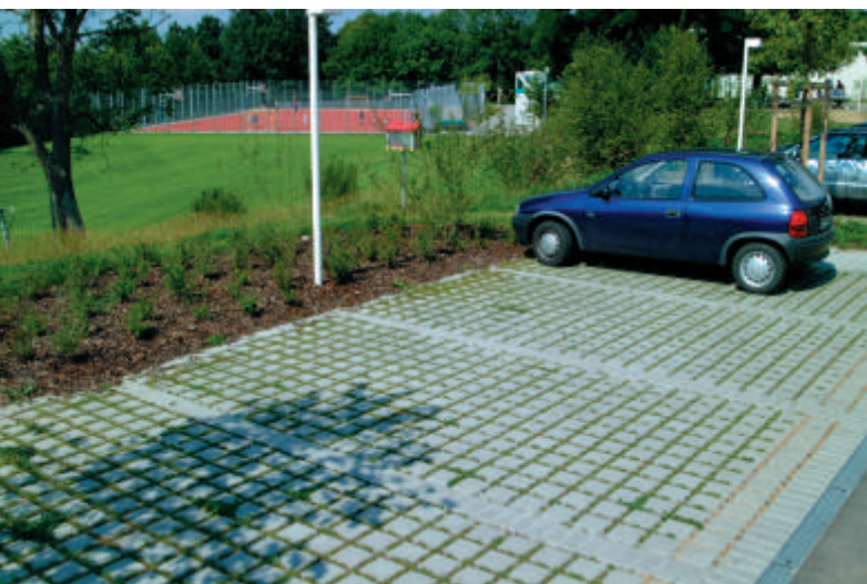
AngerFLOR 10 in Grau als Parkplatzbefestigung
