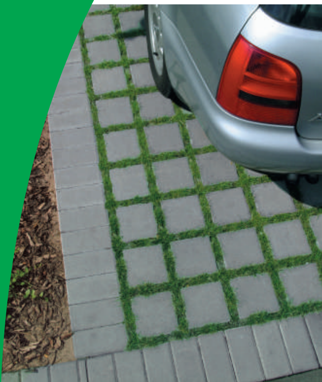
AngerFLOR 10 in Grau als Parkplatzbefestigung die Nahaufnahme zeigt schön die begrünten Fugen
