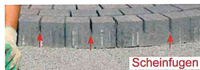
Kleinformatige Steine sind in verschiedene Steinelemente zusammengefasst
