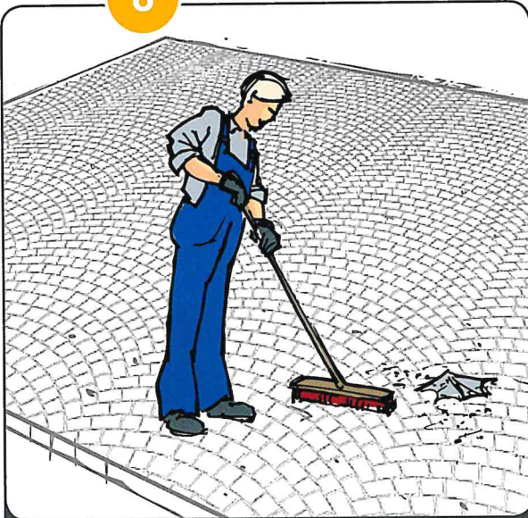
Verfugen Fläche mit Fugenmaterial auskehren
